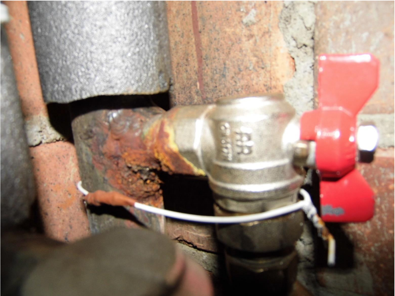
Проникающая и сквозная коррозия врезки квартирного узла в стояк ГВС:
