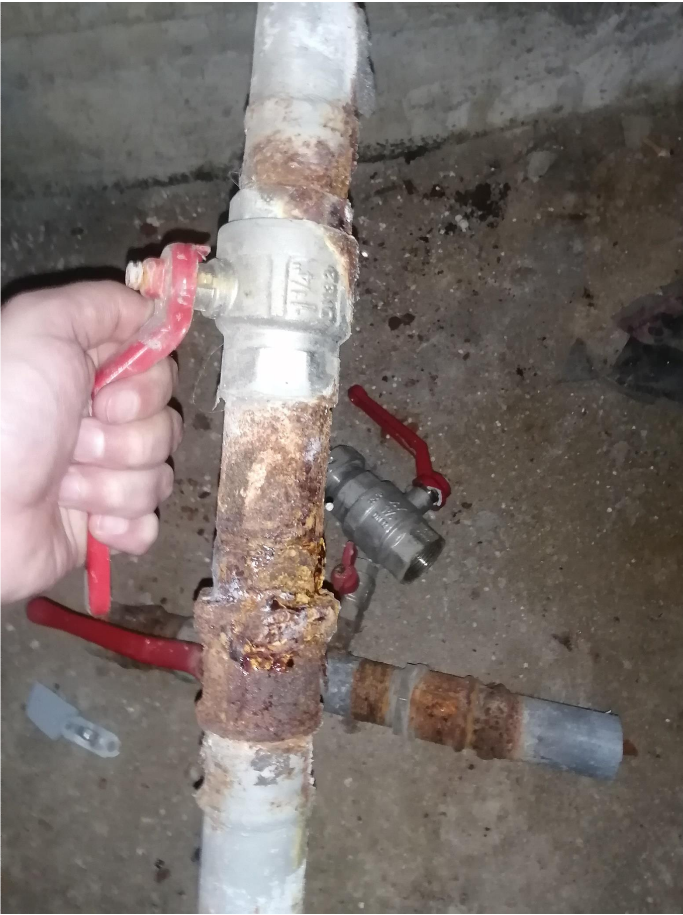
Проникающая и сквозная коррозия сгонных соединений стояков водоснабжения:
